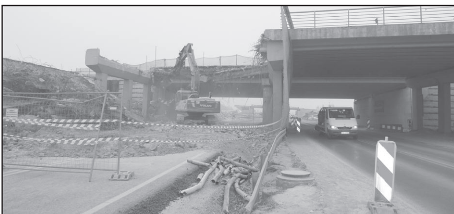
Stare wiadukty, nad drogą nr 74, muszą ustąpić miejsca nowym.
